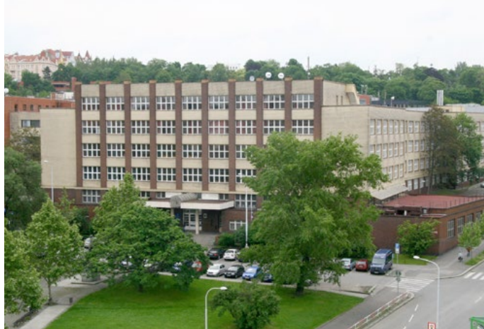
Stará budova VŠE
