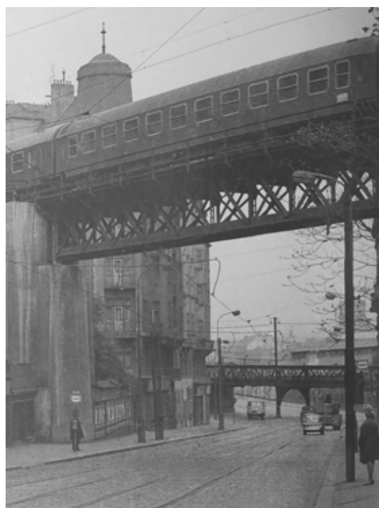
Oba viadukty v roce 1974
