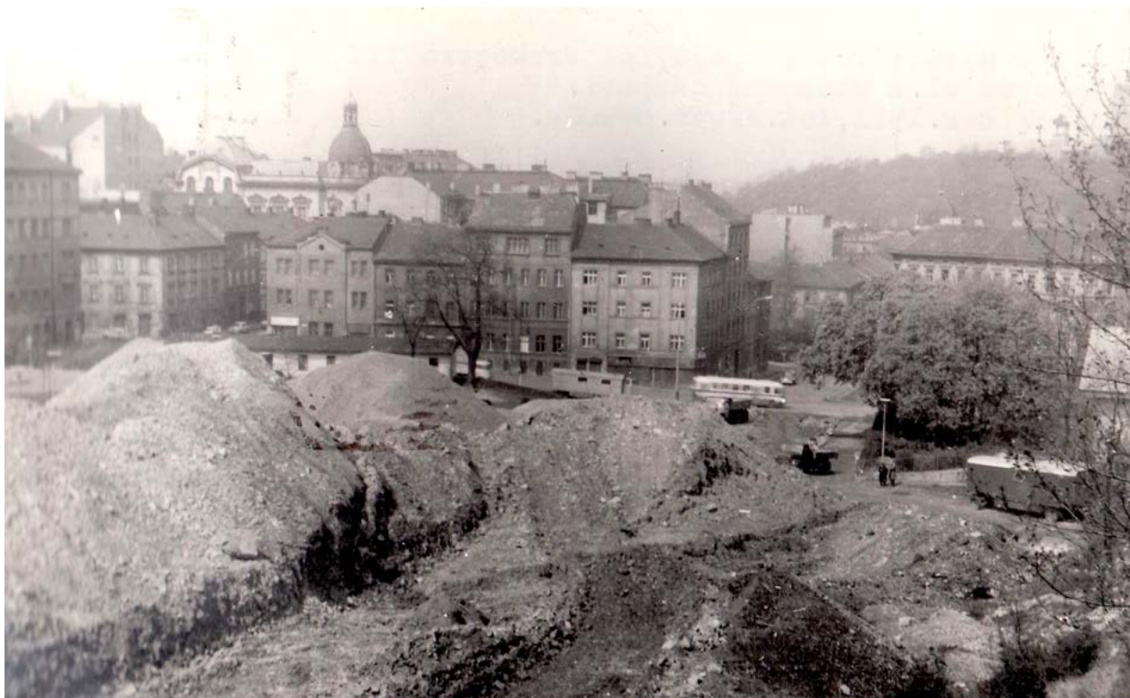
Prostor Bezovky po prokopání úpatí Vrchu sv. Kříže
