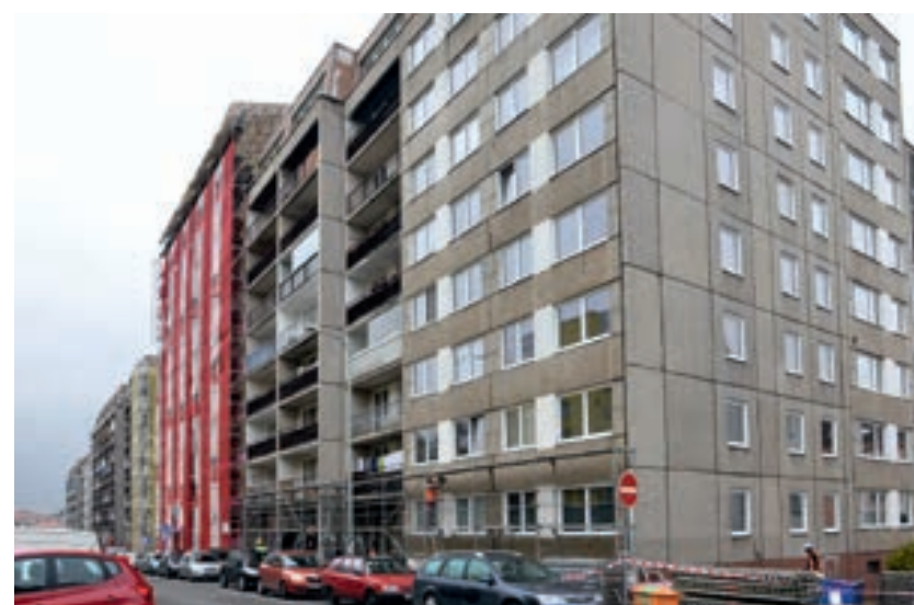
Rekonstrukce panelových domů v Jeseniově-Ostromečské jsou v plném proudu
