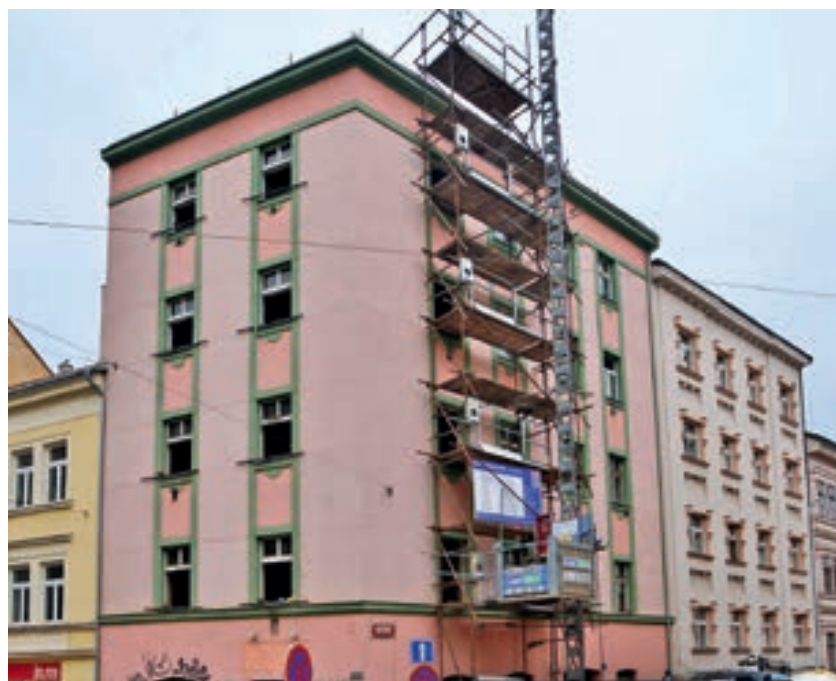
Stavební úpravy objektu Úřadu městské části v Lipanské 7 budou pokračovat i příští rok
