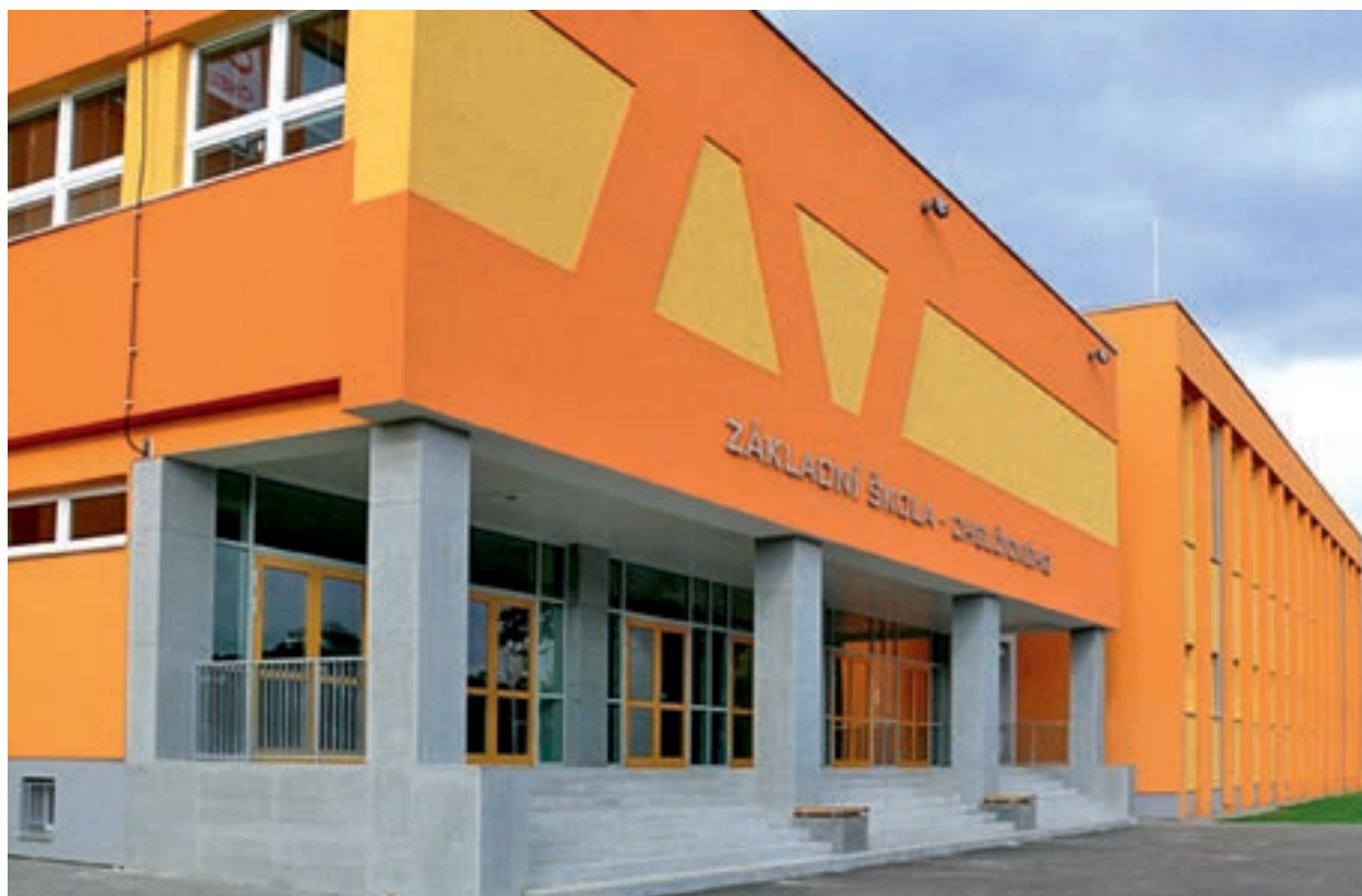
ZŠ Chelčického čeká rekonstrukce střechy
