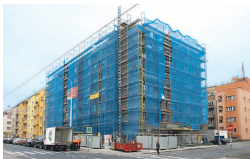
Slevy z nájemného se dočkali i obyvatelé právě opravovaného domu v ulici Za Žižkovskou vozovnou 18, který je v majetku MČ Praha 3
