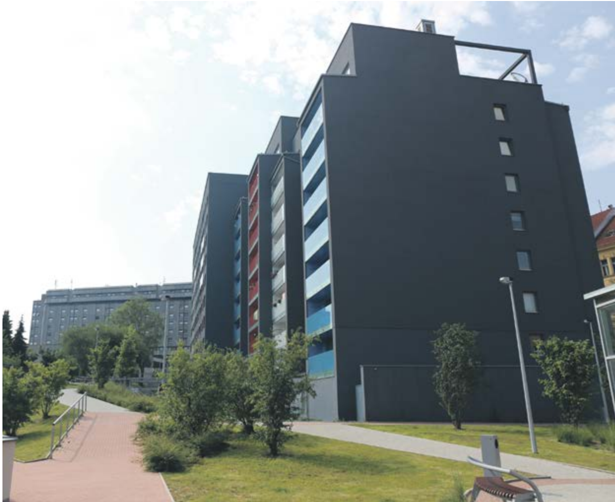
Rekonstrukci bytového domu prověřoval znalecký posudek
