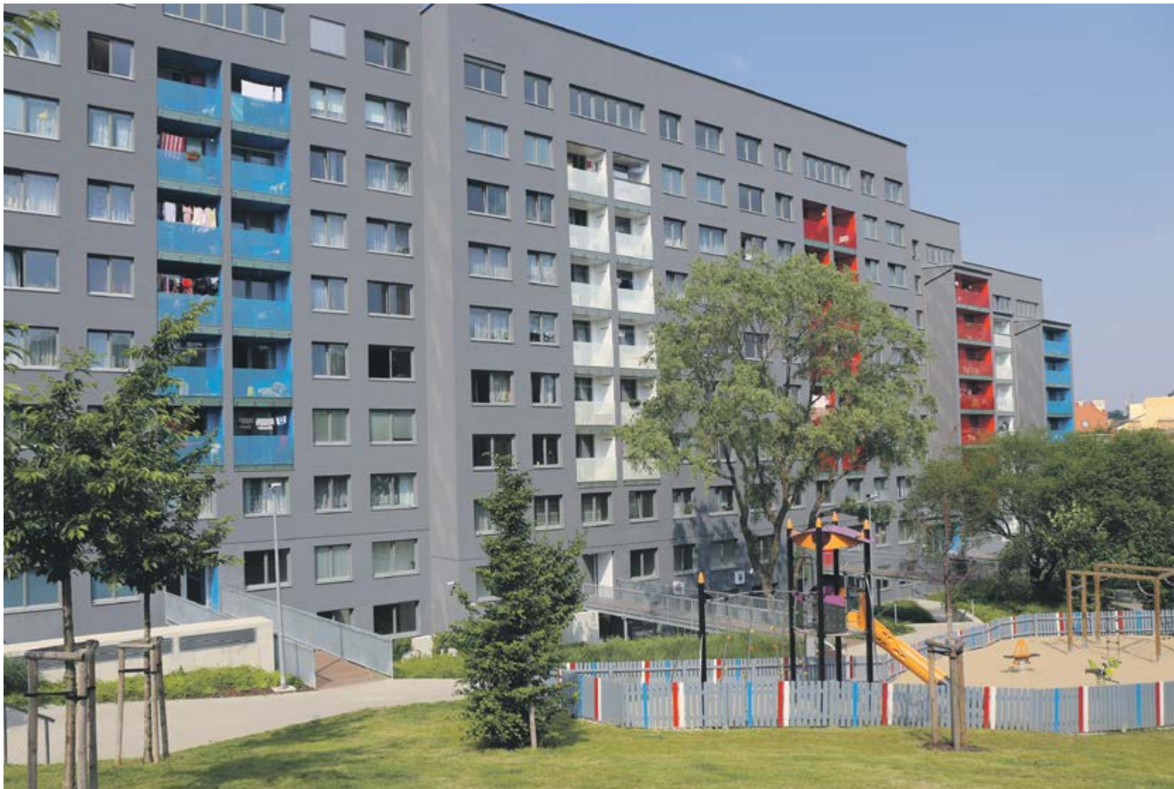
Rekonstrukce bytového domu v Lupáčově ulici vzbuzuje i po svém dokončení otázky
